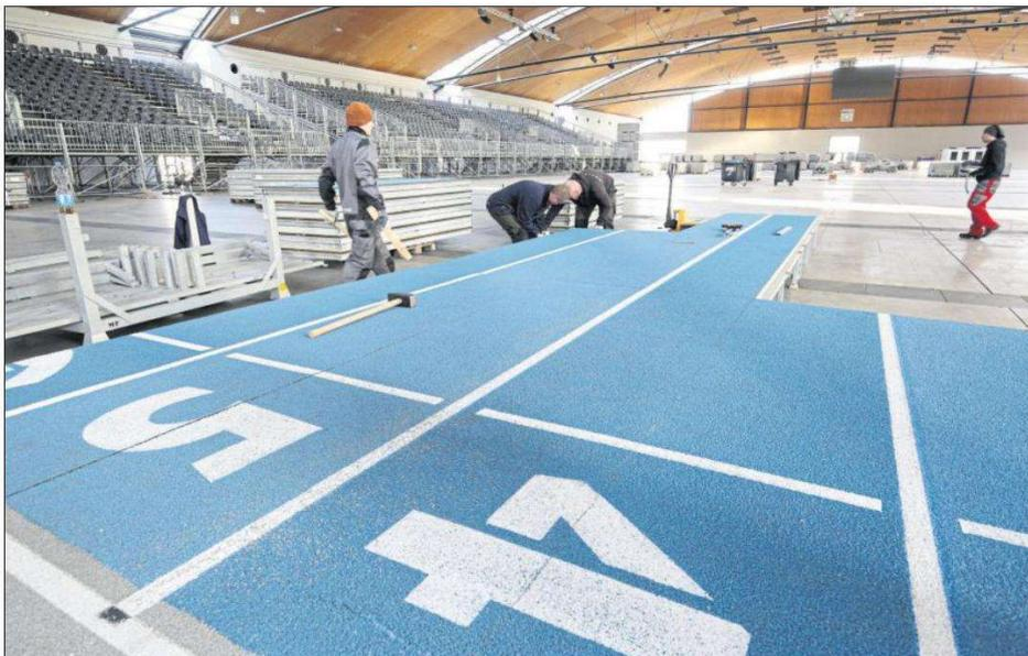
EINEM PUZZLE gleicht der Aufbau der Laufbahn und des sogenannten Infields, dessen Einzelplatten zwischen 120 und 150 Kilogramm wiegen. Für die Montage reisten Arbeiter aus Belgien und Tallinn an.
